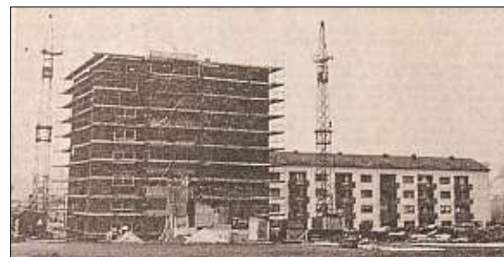
„In der Nähe des ersten Punkthauses auf dem Trostberger Feld, das im Rohbau steht, ist ein weiteres mit 40 Eigentumswohnungen geplant“, berichtet die Heimatzeitung am 25. Februar 1970.
